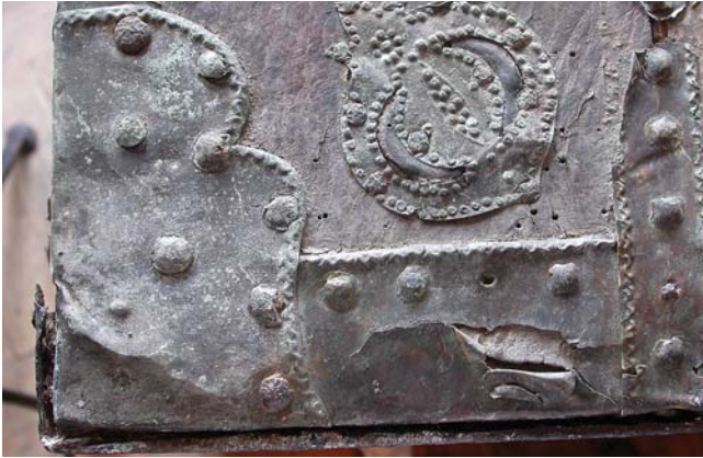
44. kép. Repedt, törött, felgyűrődött rézlemez.
