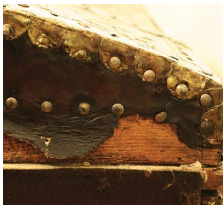
52. kép. A visszarakasztott, és szeggel rögzített „pikkely”.
