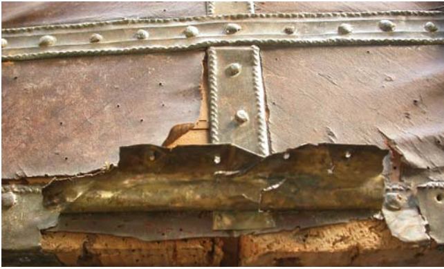
4. kép. Faalapról felvált bőrborítás, felhajlott, repedezett fémplát, rovarkárosodott faanyag.
