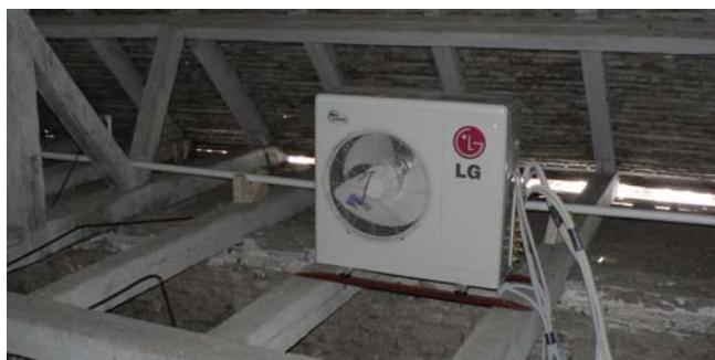
5. kép. Klimaberendezés kültéri egysége, a padlástérben.
