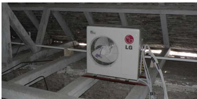
5. kép. Klimaberendezés kültéri egysége, a padlástérben.
