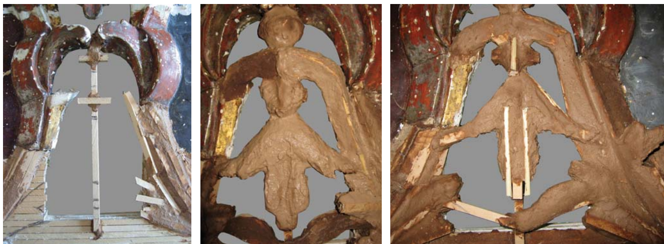
10–12. kép. Faragott díszítőelem pótlásának felépítése.
