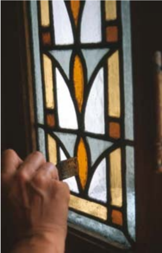
25. kép. Festékszennyeződések tisztítása a keskeny bordúrkön.
