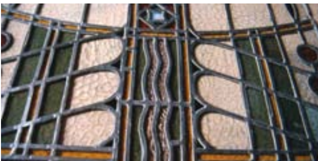
27. kép. A megtisztított ólomsínek.
