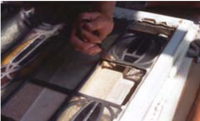
19. kép. Eltérő színű és mintázatú üvegelemek kibontása.
