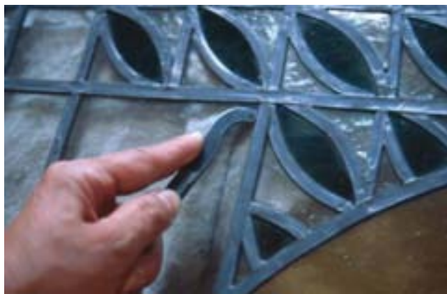
17. kép. Letisztított üvegfelület, ólomsínek lesimítása tisztítás után.
