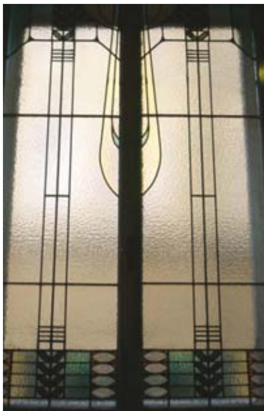
7. kép. Ablak sorosan kötött mértani szerkesztésben, nagyfelületű üvegelemekkel.
