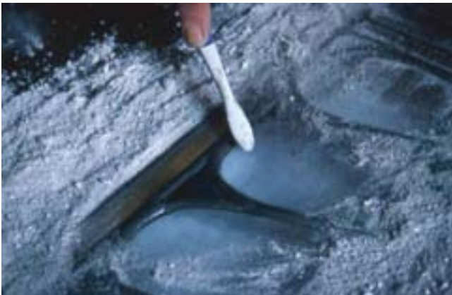
26. kép. Az ólomsínek felületi tisztítás a hézagtömítés után.
