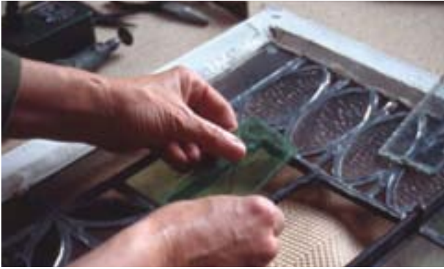
18. kép. Hiányzó üvegek pótlása.
