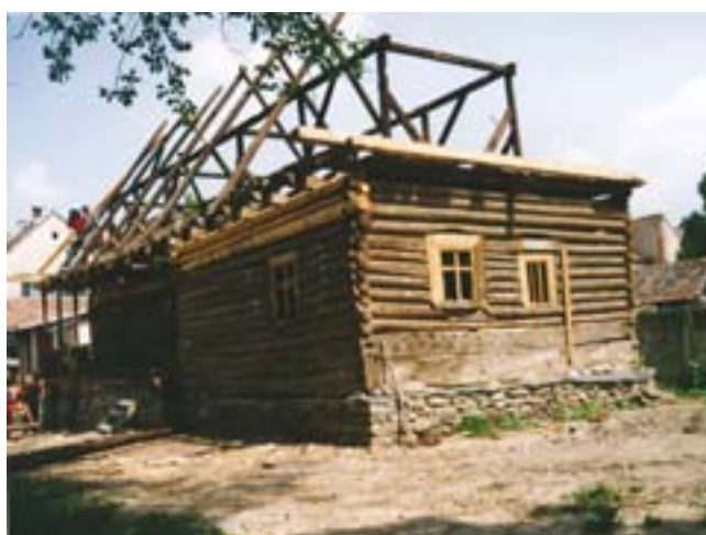
7. kép. A tetőszerkezet építése.
