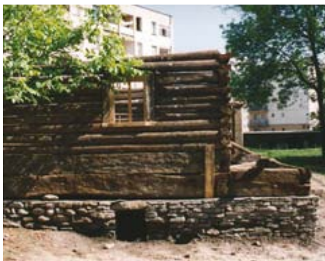
6. kép. A boronafal összerakása.
