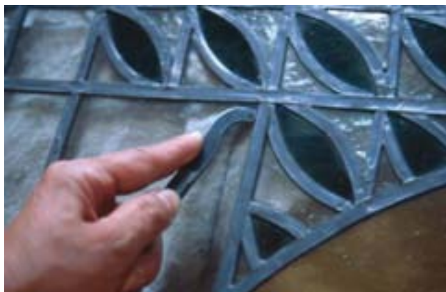
17. kép. Letisztított üvegfelület, ólomsínek lesimítása tisztítás után.
