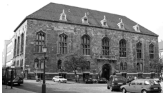
3. kép. A Hess András téri épület homlokzata.
