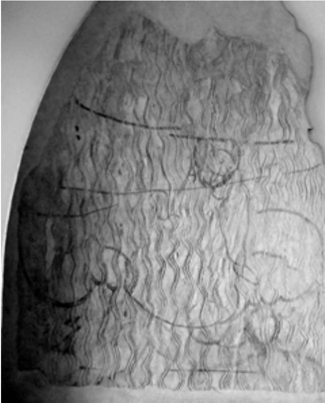
2. ábra. Barokk sinopia. Figyeljük meg az arriccio jellegzetes hullámvonalban való bekarcolását, mely a felső vakolat jobb kötését szolgálja. Firenze, Brancacci kápolna, Vincenzo Meucci műve (1746–48).
