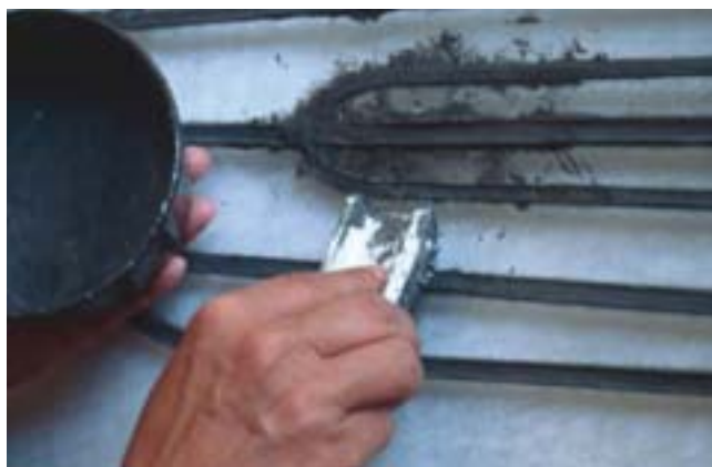
15. kép. Felnyitott ólomsínek hézagátömítése.
