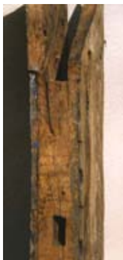
2. kép. Az ablakkeret nútja, melybe a boronákat zsilipelték.
