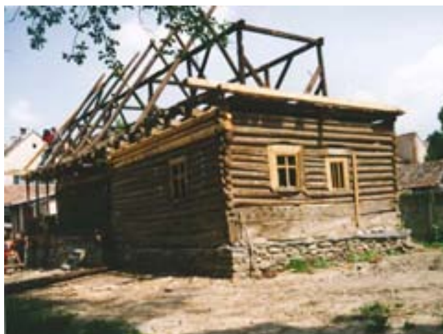
7. kép. A tetőszerkezet építése.
