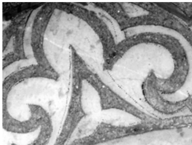
5. ábra. Perforált karton ( spolvero ) a pesterzsébeti templom sgraffitójáról. A minta kivágásakor csak nagy vonalakban követték a karton által jelzett motívumot.
