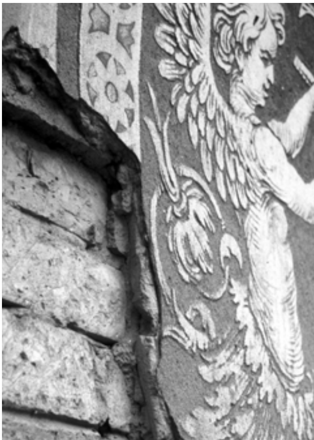
15. ábra. A meszelt sgraffito szerkezete. A falazaton egy vastag mészhomok kiegyenlítő vakolat található. Erre került a centiméteresnél vékonyabb fekete vakolat, majd a krémszínű meszelés. A keret díszítése patron mintával készült, freskóban. Budapest, Akadémia u.
