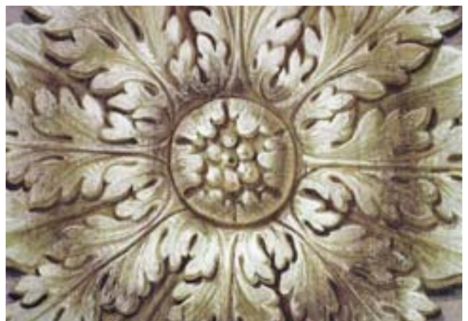
37. kép. Rozetta-stukkó imitáció, vegyes szekkó technikával. A világos színek mésszel készültek, a sötétek talán enyvvel.
