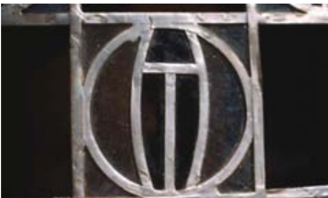
21. kép. Az ólomsínek szilárdsága megfelelő az új elemek beépítéséhez.
