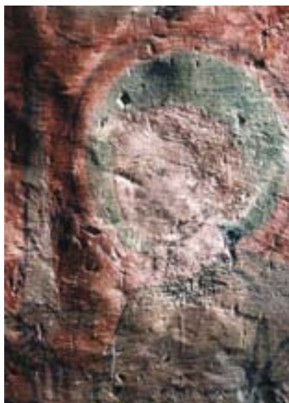
27. kép. Ugyanez súrló fényben. Jól látszik a jellegzetes középkori, hullámos és durva felületű vakolás.
