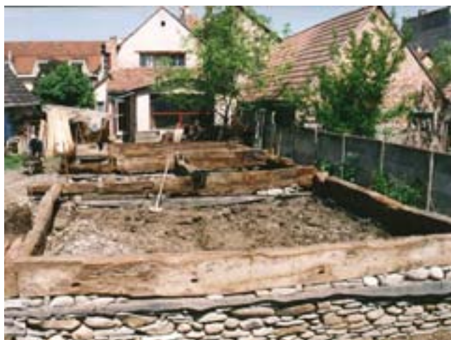
5. kép. A tarcsafalvi lakóház talpgerendáinak lerakása.
