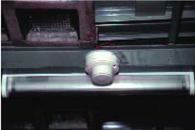
20. kép UV szűrővel ellátott világítótest és füstérzékelő
