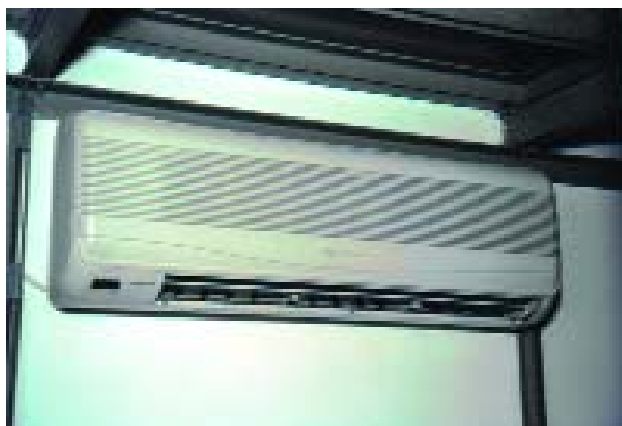
19. kép Falra szerelt légkondicionáló készülék
