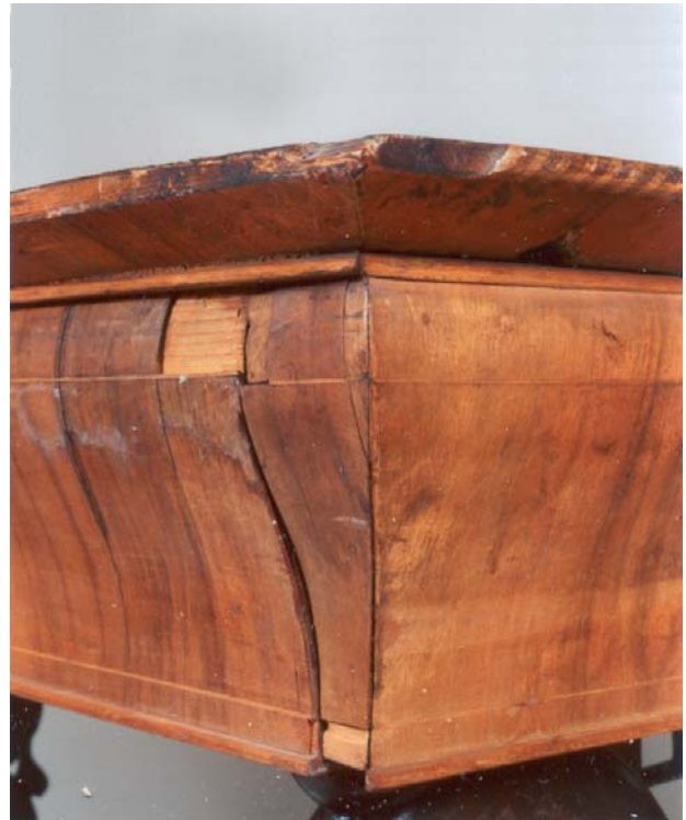
2. kép. Nedvesség hatására felvált borítás
