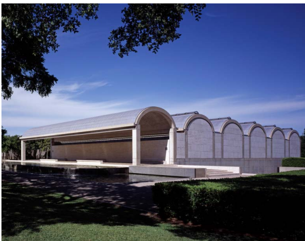
18. ábra. Kimbell Art Múzeum (Fort Worth, Texas) előkertjének tetőszerkezete is ciklois.
