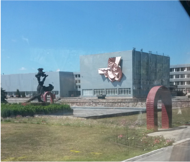
17. ábra. Érkezés az 1. blokk épületéhez.
