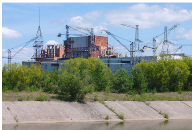
8. ábra. Az 5. és a 6. „épülő” blokk maradványai.
