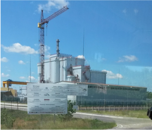
9. ábra. A kiegészített nukleáris üzemanyagok épülő, száraz típusú hulladékátrolója.
