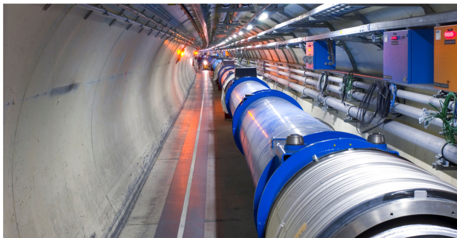
2. ábra. Az LHC alagútja a mágnesekkel.
