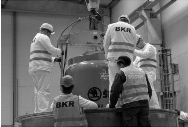
5. ábra. A VPVR/M konténer betöltése a „huzat”-ba.
