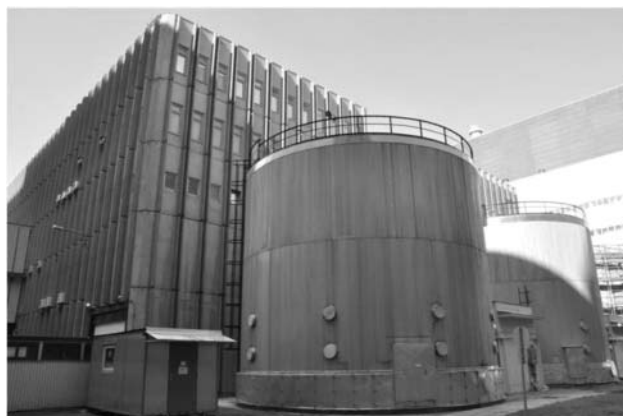
2. ábra. A II. kiépítés sótalanvíz-rendszerének tartályai.
