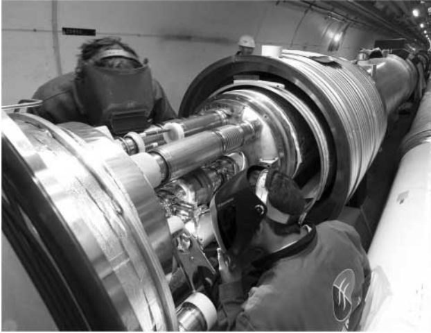
4. ábra. Mágnes beillesztése a gyorsítóba. Technikusok az előtérben végződő dipólusmágnes vákuum- és hűtőrendszerét, csatlakozóit hegesztik.
