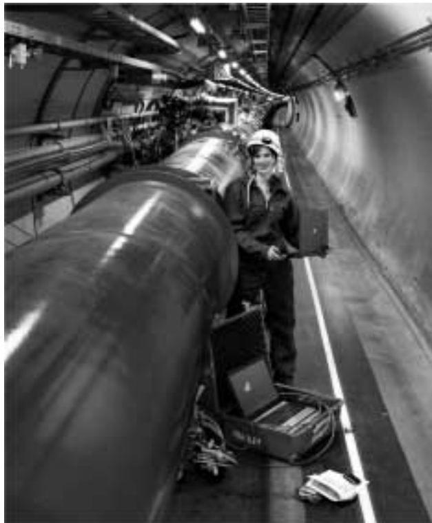
7. ábra. Az épülő LHC kriogén rendszere elektronikájának ellenőrzése. (foto: CERN, 2007.)
