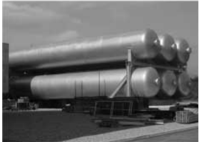
Az ATLAS detektor szupravezető mágnesének hűtéséhez használt hélium tárolása a CERN-ben.
