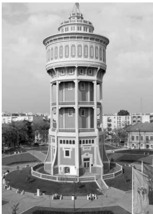
1. ábra . Magyarország első vasbeton víztornya (fotó: Becker Ottó).
