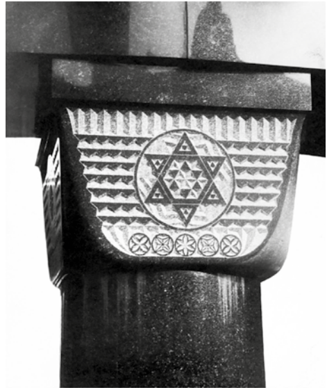
6. Gránit kockafejezet Bródy József és családja síremlékéről 1908-ból a Salgótarjáni utcai izraelita temetőből (1908. Tervező: Lajta Béla) © Lajta Béla Virtuális Archívum/Budapest Főváros Levéltára
