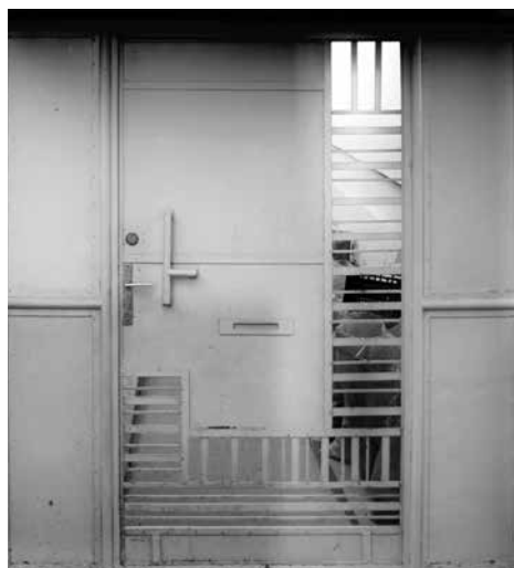
A Horea (Gr. Andrásy Gyula, a két háború között Nicolae Zigre) út 43. szám alatti ház modernista lemezkapuja. Egyszerű mondanivaló, vonzó kivitelezés © Zuh Deodáth
