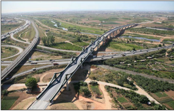
20. ábra Sant Boi de Llobregat (2007) viadukt Barcelona mellett
