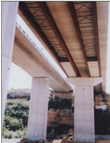
22. ábra Mijares híd, Betexi-Borriol, Castellón (2004)
