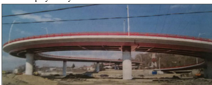
38 – 39. ábra DN1 közúti felüljáró, Campina (2012)
