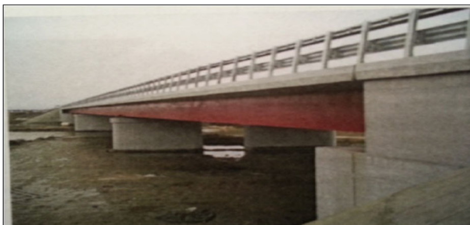
37. ábra Arges-híd (A1) autópálya (2007)
