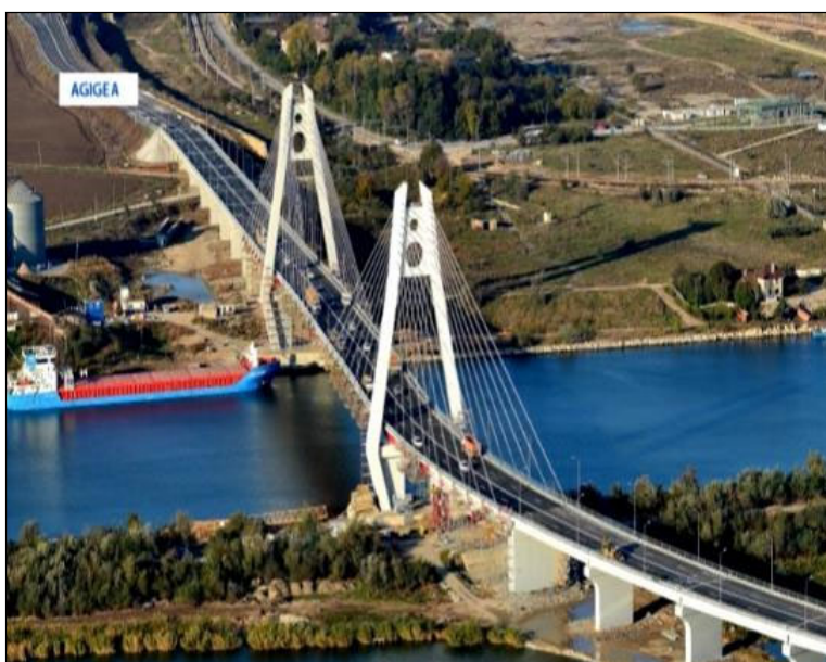
40. ábra Új Agigea híd (2016)
