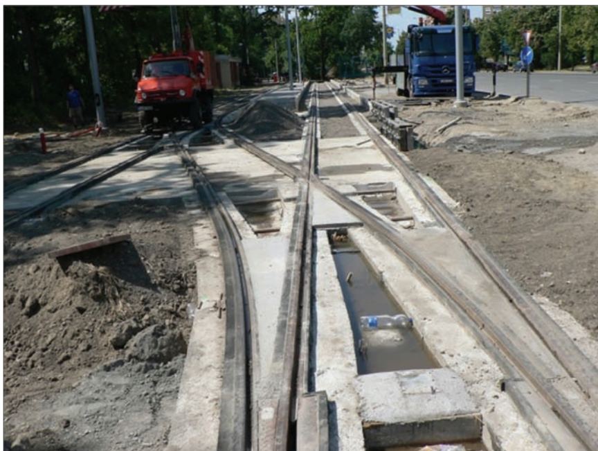
Szeged 2 sz. villamosvonal CDM r. fűvesített kitérő, építés közben. Végállomás hurok vágány
