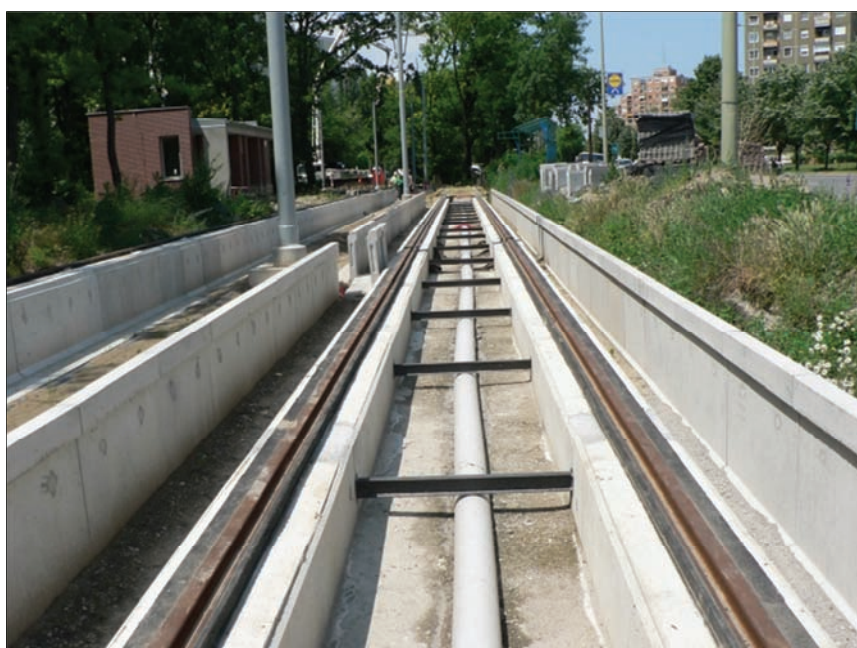
Szeged 2 sz. villamosvonal CDM r. vágány peronnal, felépítményi szivárgóval építés közben. Végállomás hurok vágány, vb gerenda I 80 összekötő elemekkel
