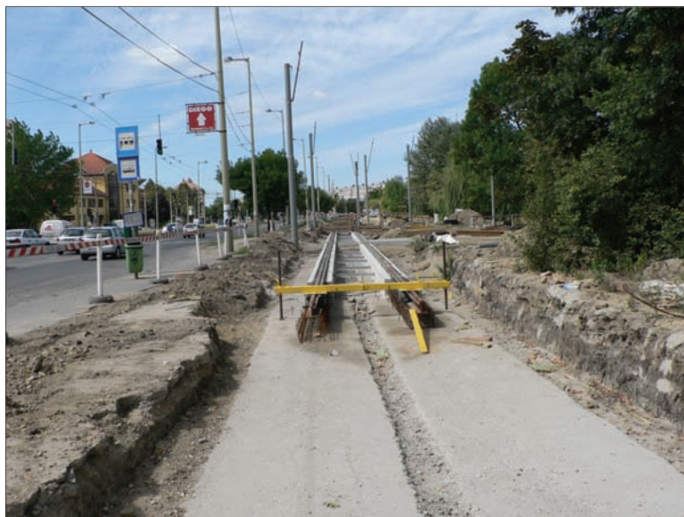
Szeged 2 sz. villamosvonal CDM r. fűvesített szakasz, építés közben. Rókusi krt.
