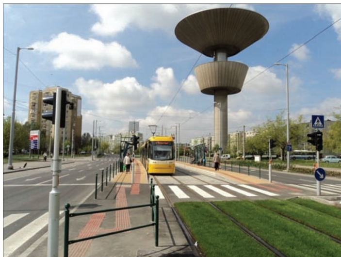
A megépült Szeged 2 CDM rendszerű élőfüves pálya
