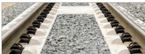
5. ábra: Lemezaljas pályaszerkezet
