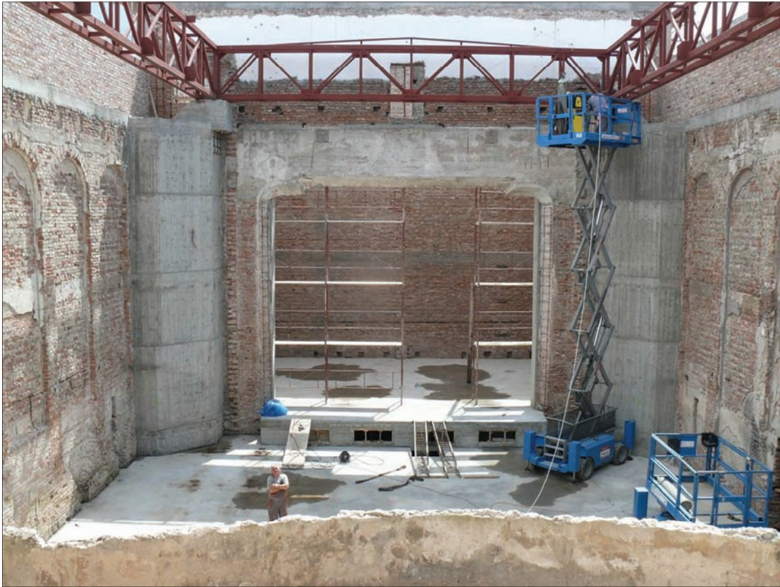
4. ábra A balázsfalvi kultúrpalota belseje, felújítás közben.
