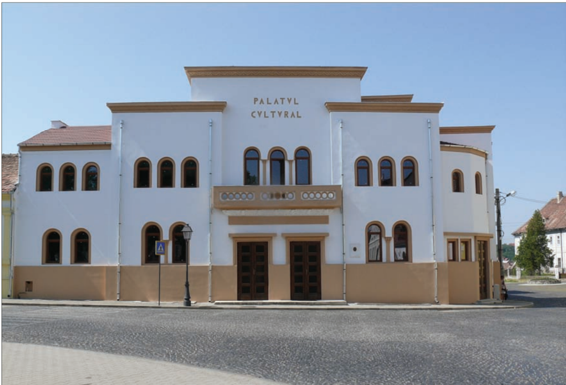
5. ábra A balázsfalvi kultúrpalota felújított homlokzata.
