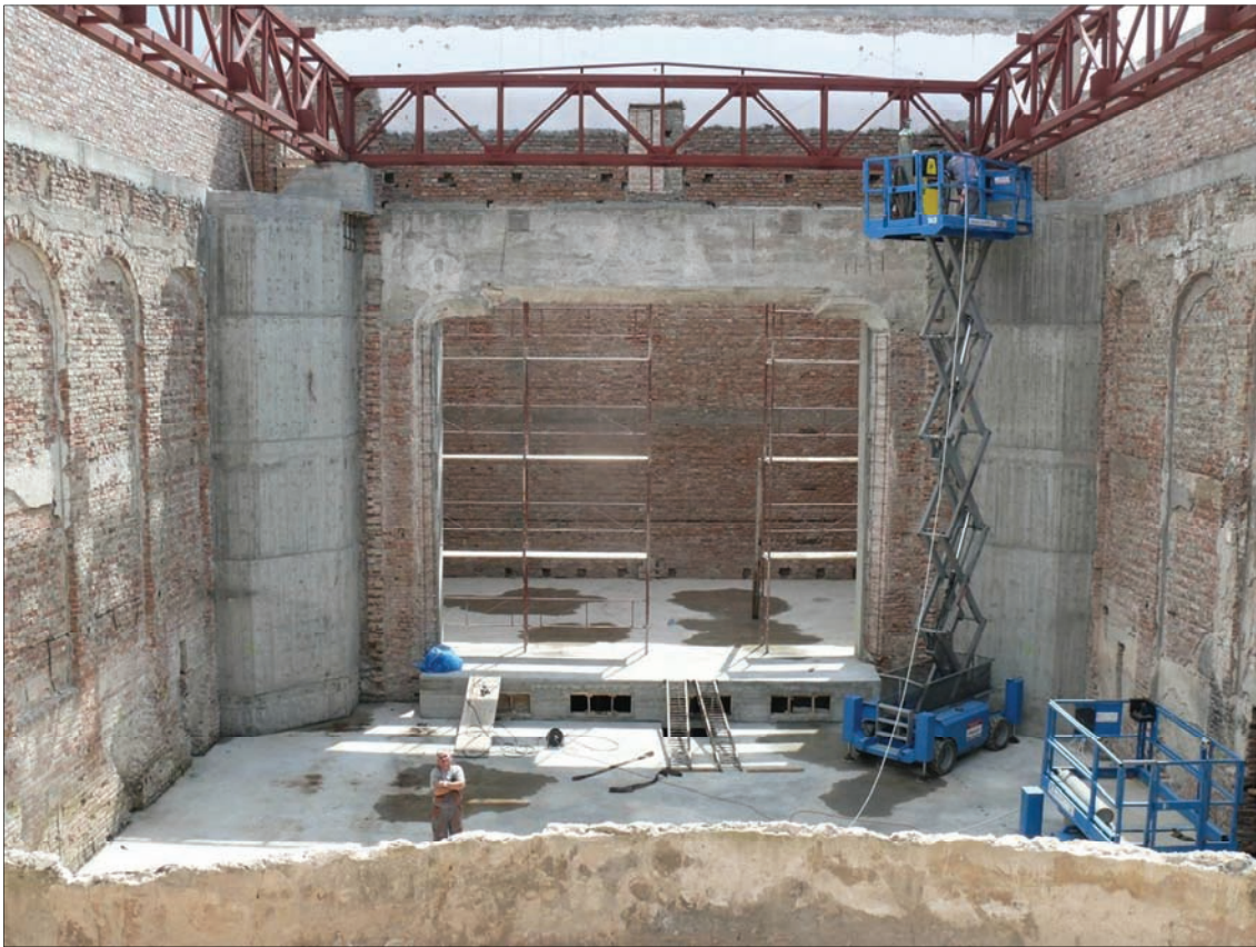
4. ábra A balázsfalvi kultúrpalota belseje, felújítás közben.
