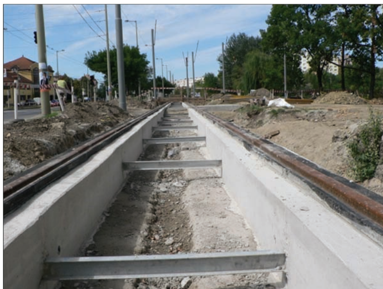
Szeged 2 sz. villamosvonal CDM r. fűvesített szakasz, építés közben I 80 tartókkal. Rókusi krt.
