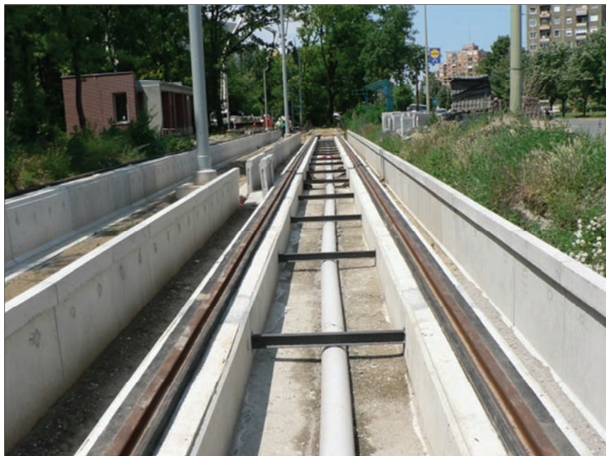
Szeged 2 sz. villamosvonal CDM r. vágány peronnal, felépítményi szivárgóval építés közben. Végállomás hurok vágány, vb gerenda I 80 összekötő elemekkel
