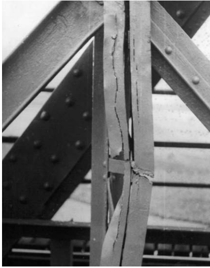
7. ábra Ütközés okozta rideg törés egy előregeredett acéltartón
