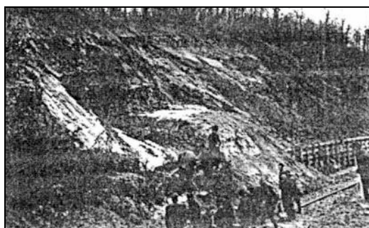
14. ábra A felépítmény részlegesen betakarva, a vonal lezárva
