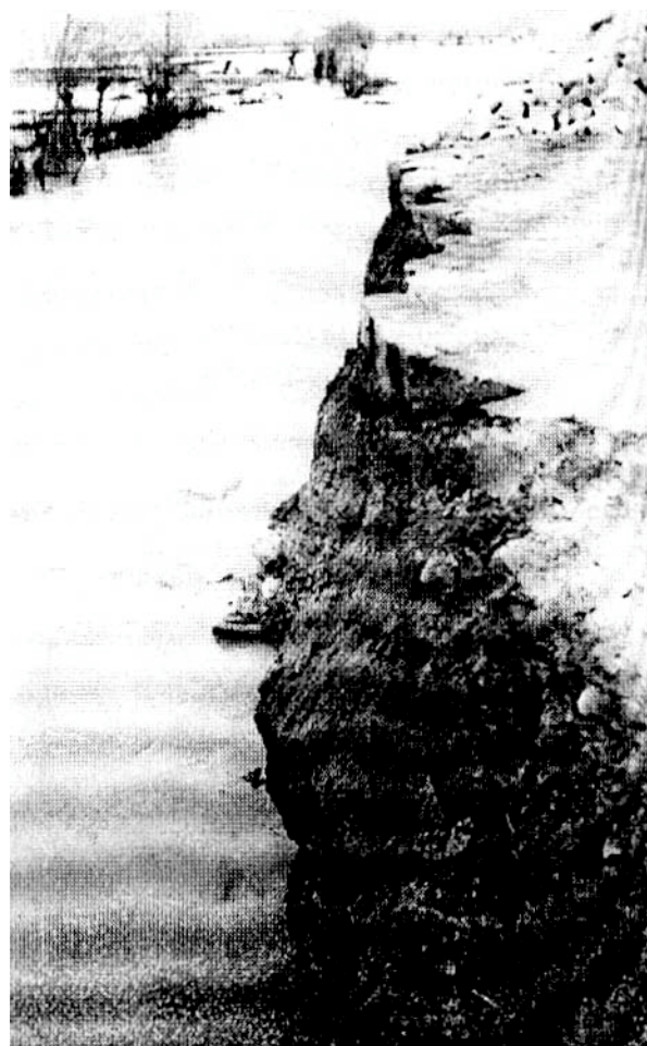
14. ábra. Az átszakított közúti töltés, a hídfő ellenfala közelében.
