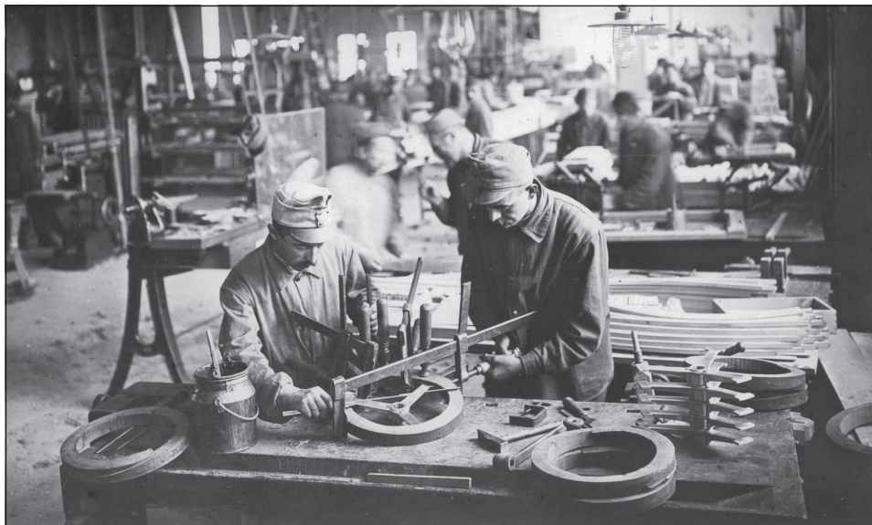
20. kép: A repülőgép-kormány készítésének első lépései
